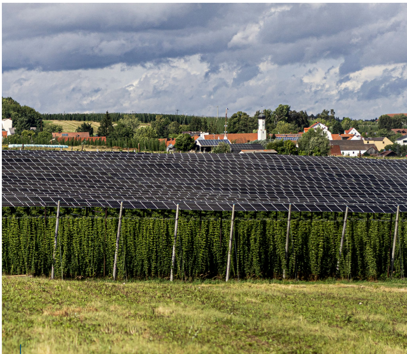
Photovoltaikanlage über einem Hopfenfeld in der Hallertau: Triple Win für den Hopfenbau. Neben Hopfen wird auch Strom erzeugt, während zugleich Pflanzen vor viel Sonne und Hagel geschützt werden.
